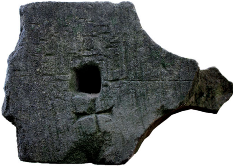
Abb. 4: Klosterruine Disibodenberg, Gewölberippe mit Mittenritzlinie, Zapfenloch und Versatzzeichen in Kreuzform (© Wilfried E. Keil).
