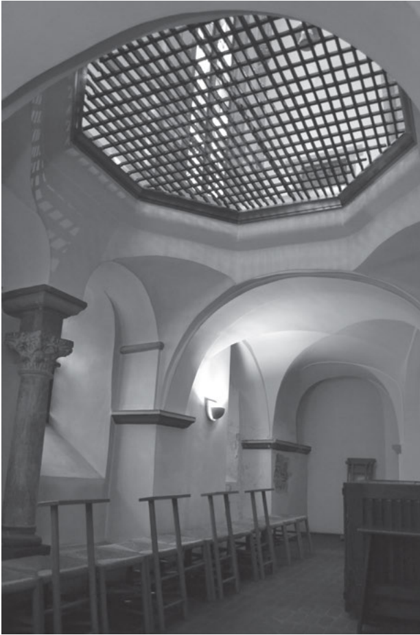
Abb 8: Südöstlicher Teil der Krypta, Blick nach Westen, Münsterkirche Essen (Foto: Autorin).
